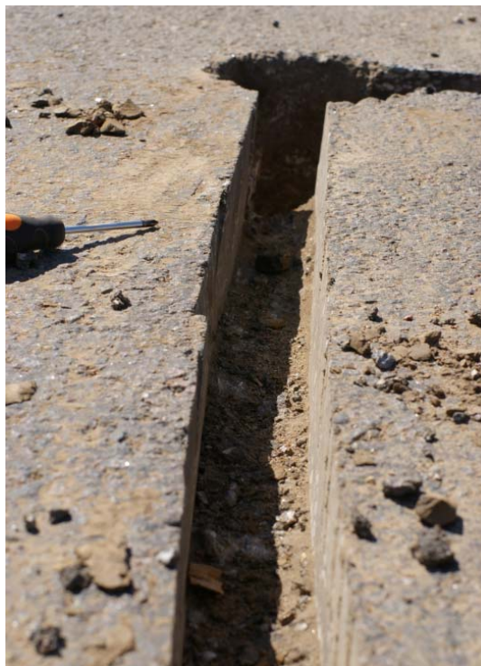
4.6 pav. Iškarta asfalto dangoje temperatūros ir drėgnio daviklių laidų nuvedimui nuo kelio vidurio į kelkraštį
