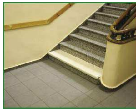
12 pav. Kontrastingai pažymėta pirmą ir paskutinę laiptų pakopą
