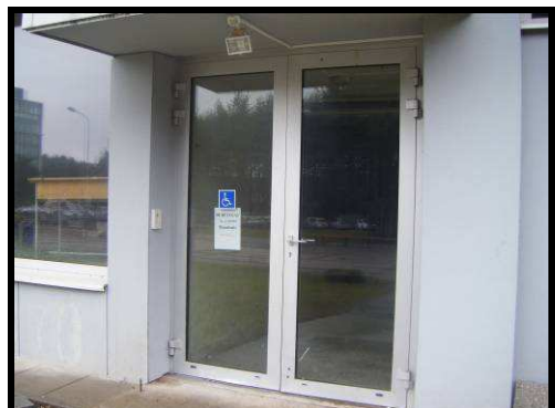
A.54 pav. Pagrindinio įėjimo durys iš smūgiams atsparaus stiklo, bet be išpėjamosios juostos
