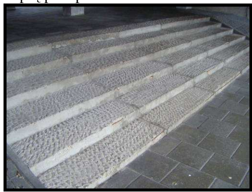
A.6 pav. Laiptatakių išpėjamųjų paviršių nebuvimas
