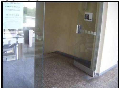
A.78 pav. Stiklinės durys ir jų žymėjimas išpėjamąja juosta
