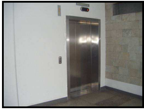
A.56 pav. Lifo kabina ir jo durų anga, aikštelė prieš liftą
