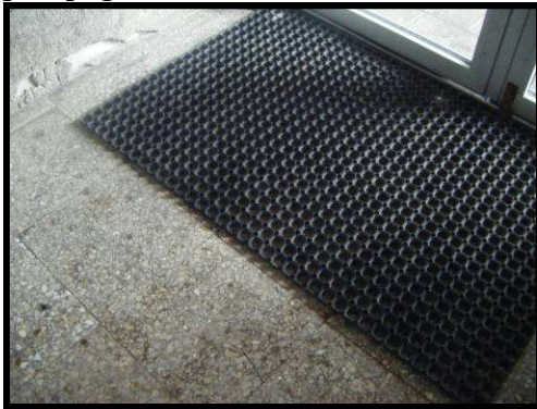
A.11 pav. Neįgilinti kojų valymo prietaisai prie pagrindinio įėjimo
