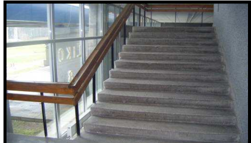
A.50 pav. Vidaus laiptų pakopos, Turėklų stveriamosios konstrukcijos, tiesūs laiptatakliai
