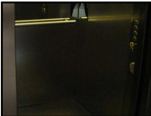
A.59 pav. Turėklai lifto kabinos viduje
