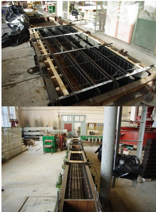
19 pav. Eksperimentinių sijų betonavimas
