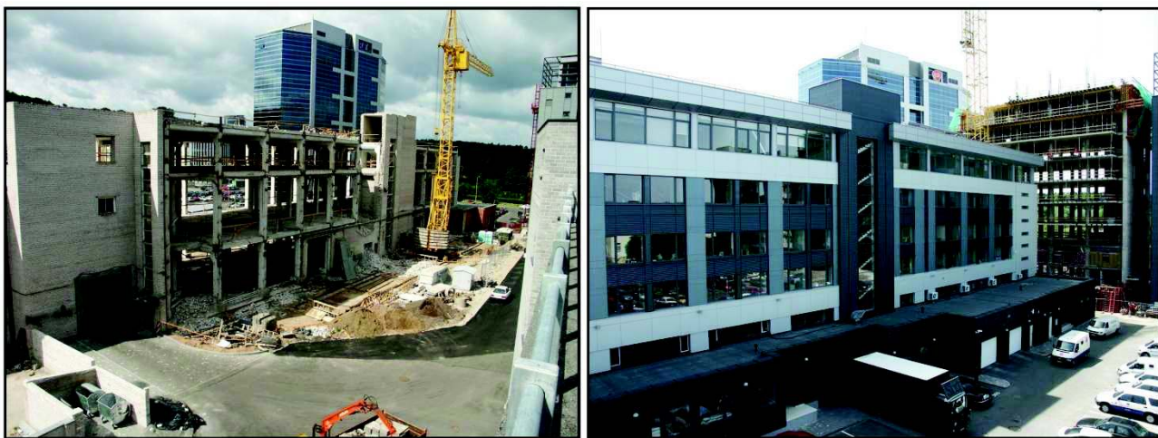
34 pav. Buvusio batų fabriko Goštauto gatvėje sandėlio konversija: a) rekonstrukcijos darbai, b) bendras vaizdas
