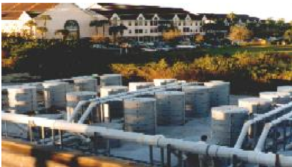
1. 29 pav. Venturi biofiltrai
