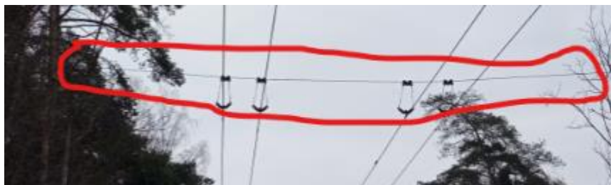
2.19 pav. Skersinis lynas (šaltinis: http://www.troleibusas.lt )
