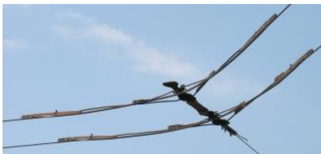
2.14 pav. Kreivės laikiklis (šaltinis: http://www.troleibusas.lt )
