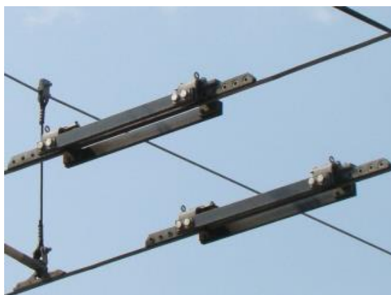
2.10 pav. Sekcijinis izoliatorius (šaltinis: http://www.troleibusas.lt )
