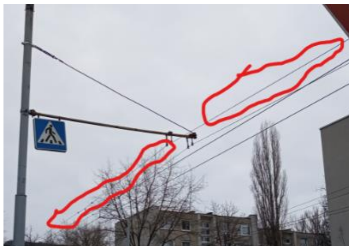
2.18 pav. Išilginis lynas (šaltinis: http://www.troleibusas.lt )
