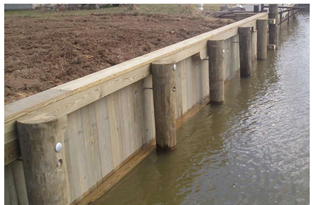
8 pav. Įrengti mediniai poliai (Steel Giant, 2023)
