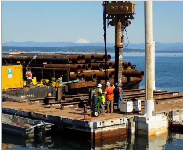
5 pav. Plieninių polių kalimas (Flickr, 2023)
