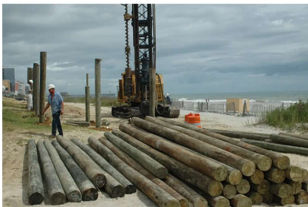
7 pav. Medinių polių kalimas (Koppers, 2023)
