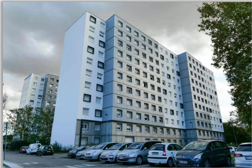
2.7 pav. Prancūzijoje esančio daugiabučio namo modernizavimas (Energiesprong, 2022)
