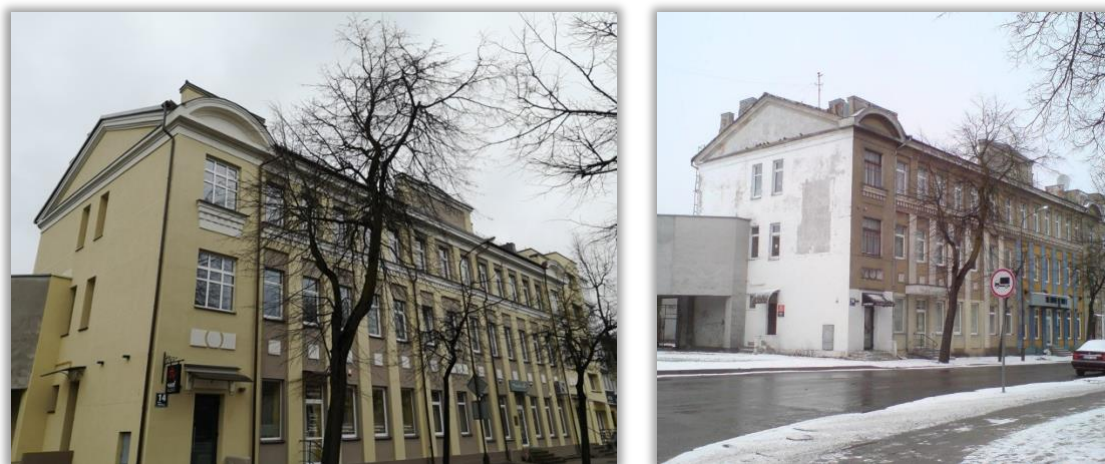
2.3 pav. Modernizuotas Šiaulių daugiabutis namas (Visockienė, 2021)
