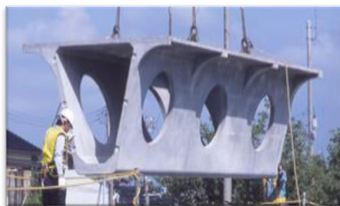
1.7 pav. Sakata Mirai pėsčiųjų tiltas (2002 m., Japonija); a) bendras tilto vaizdas; b) skerspjūvio forma (Infrastructure... 2012; Ductal 2014)
