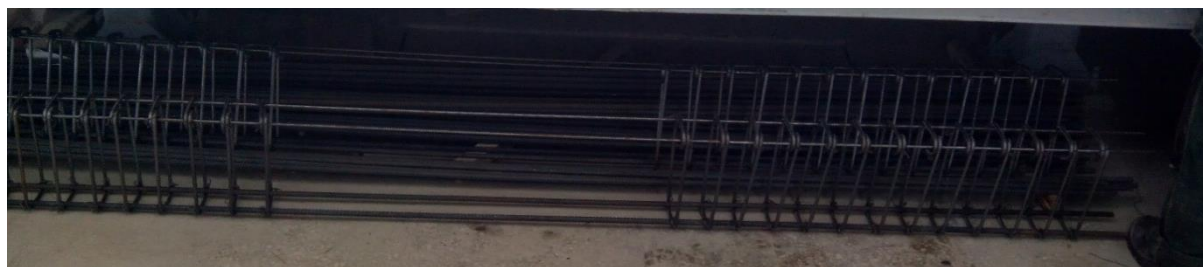
2.12 pav. Sijų armatūros karkasas
