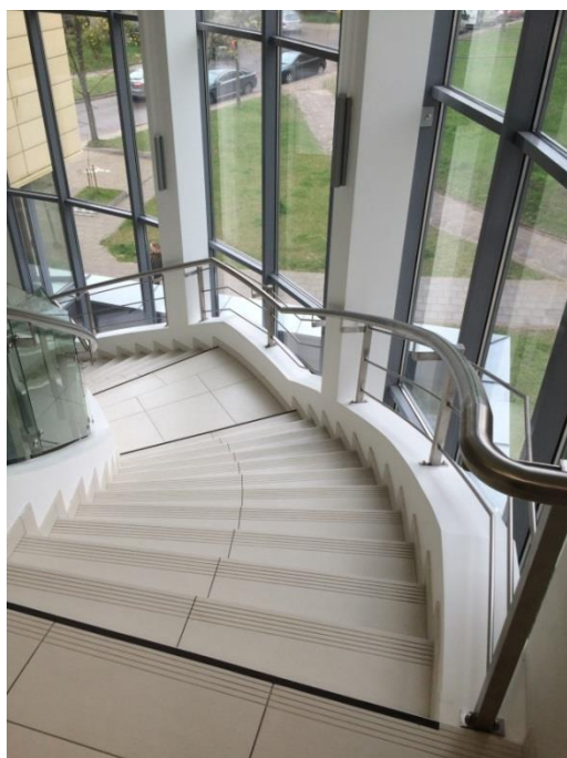
3.20 pav. Laiptai, jų paviršiaus žymėjimas
