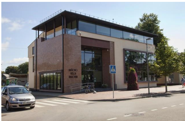
3.1 pav. Birštono miesto biblioteka po atnaujinimo (Birštono bibliotekos... 2013)
