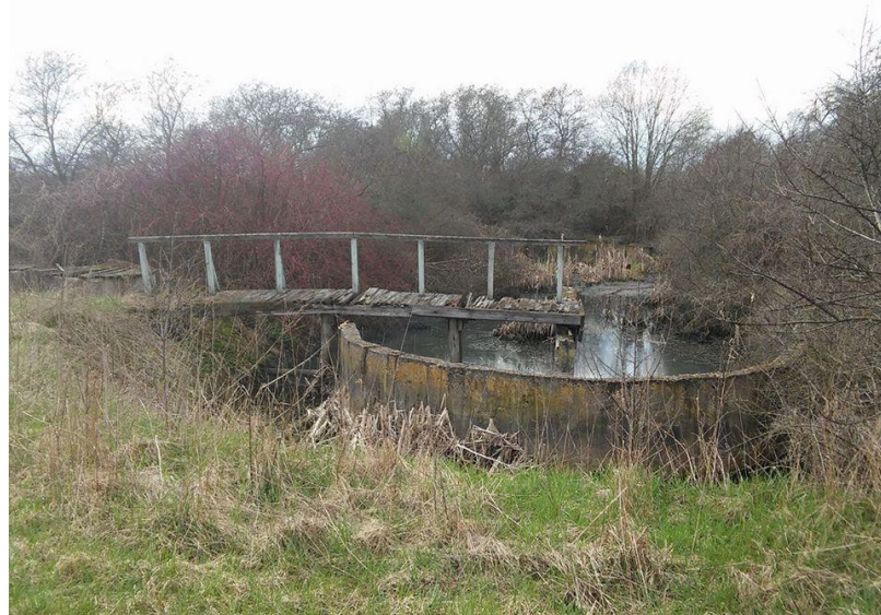
14 pav. Sutrupėję ir nesandarūs gelžbetoniniai elementai (autorius nuotrauka)
