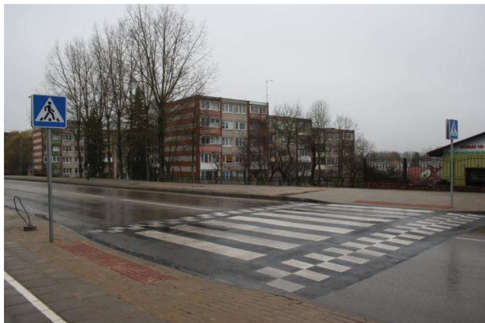
16 pav. Iškilioji pėsčiųjų perėja pritaikyta aklujų ir silpnaregių poreikiams
