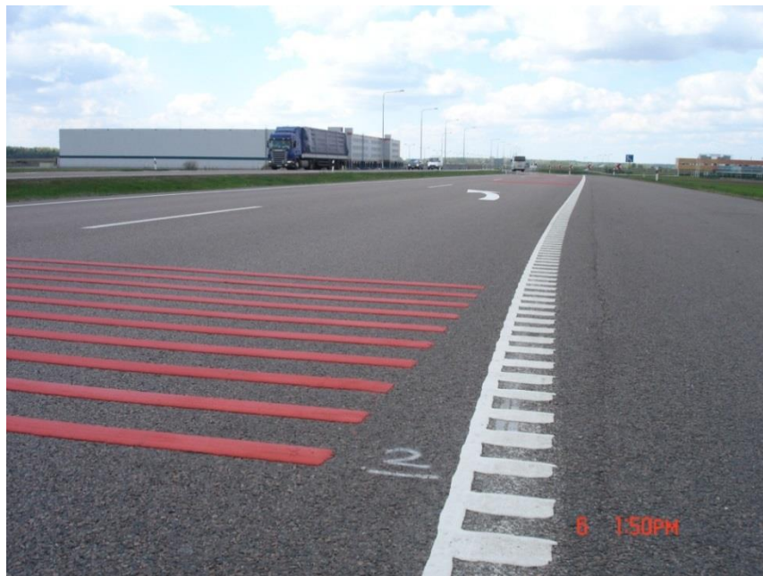
11 pav. Išilginio struktūrinio ženklavimo triukšmo juosta
