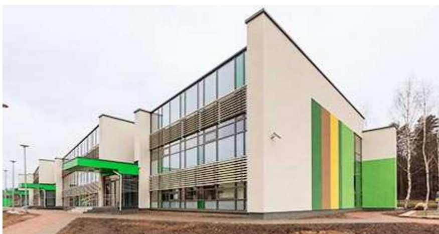
9 pav. Vaikų lopšelio–darželio pastatas (Santariškių vaikų lopšelis–darželis sprendiniai 2015)
