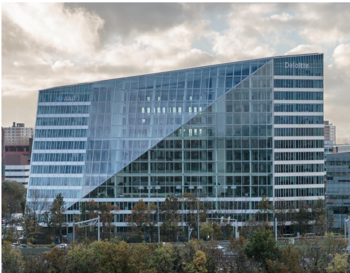
7 pav. „The Edge“ pastatas Amsterdame (Schneider electric, 2016)
