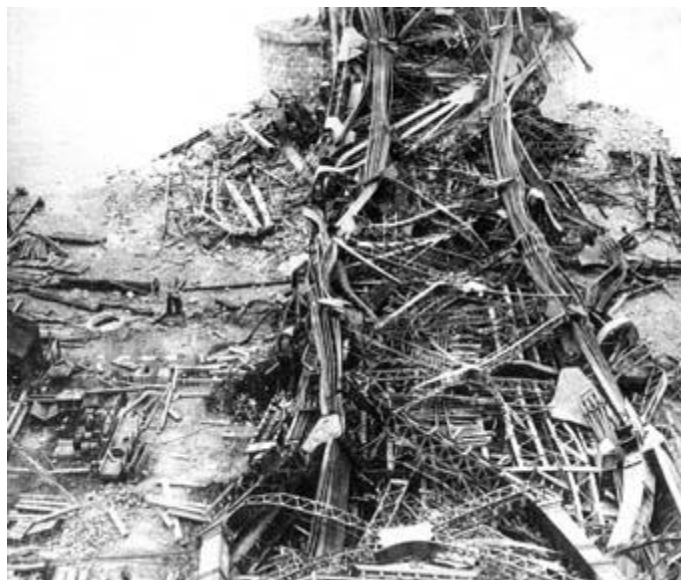
1.2 pav. Kvebeko tilto griūtis 1907 m. [4]
