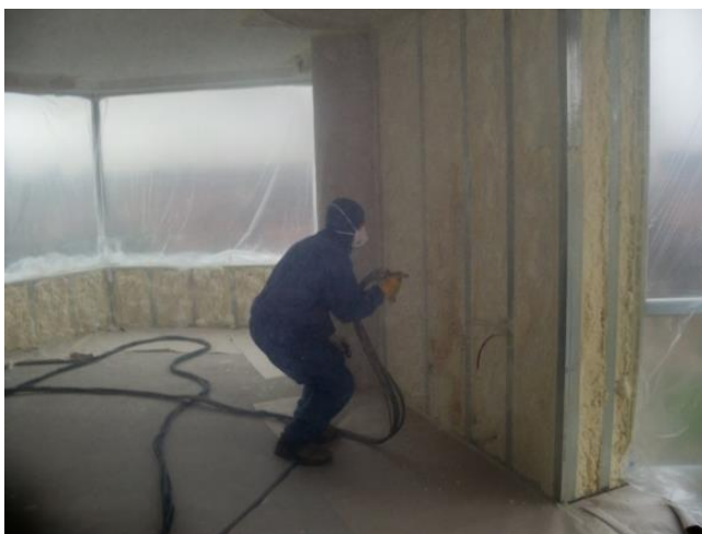
1.2 pav. Apšiltinimas putų poliuretanu (termolitas)
