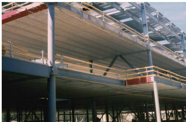
1.3 pav. Mišrios konstrukcijos pavyzdys. Laikantysis karkasas sudarytas iš surenkamųjų gelžbetoninių kolonų ir tuščiavidurių perdangų, atremtų ant tėjinio profilio metalinių sijų (Elliot & Hamid, 2017)
