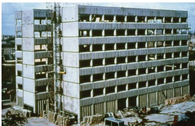
1.2 pav. Modulinio pastato karkaso pavyzdys (Elliot & Hamid, 2017)
