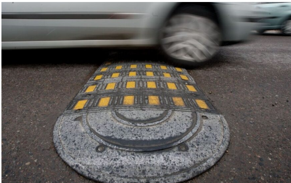
7 pav. Išskirti inžinerinė priemonė – kalnelis (paimta iš http://www.keliozenklai.lt 2020-01-14)
