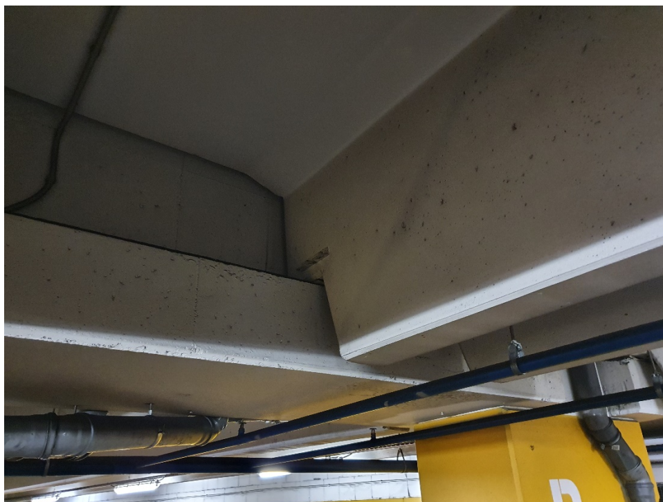
1.15 pav. Briaunos TT plokštės, atremtos ant apverstų T formos sijų prekybos ir laisvalaikio centre „Panorama“, Vilniuje
