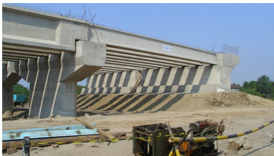
1.4 pav. I formos skerspjūvio tiltinė sija su įpjova (Bastian, 2017)
