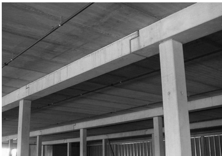
1.9 pav. Sija su įpjova kaip įterptinė sija (Elliot, 2016)
