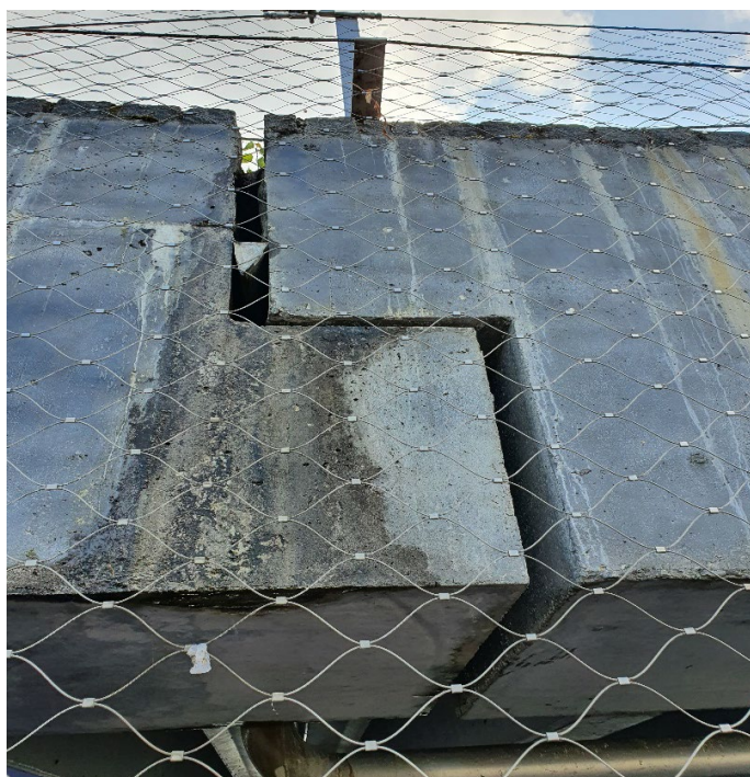
1.11 pav. Sija su įpjova Žalgirio arenos automobilių stovėjimo aikštelėje Kaune
