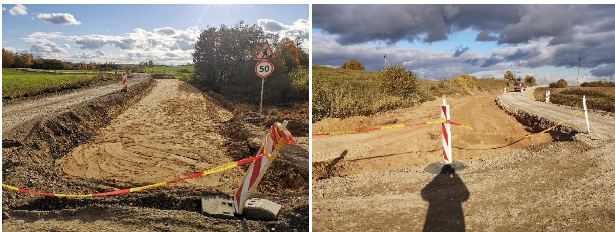
3.9 pav. “STOP” juostos panaudojimas TEK K/I 5 darbo zonoje ( fotografuota autoriaus, 2021)
