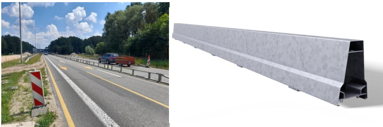
2.14 pav. Surenkami laikinieji kelio atitvarai ( www.naujienuitiltas.lt )
