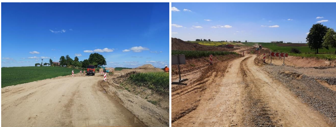
3.15 pav. Iškasos apvažiavimo koridorius (fotografuota autoriaus, 2021)
