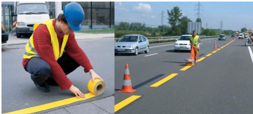
2.13 pav. Kintamos informacijos ženklai kelio darbų zonoms a) nuplaunami dažai ( www.lindsay.com ); b) klįjuojama laikina horizontaliojo ženklavimo juosta ( www.jugima.lt .)
