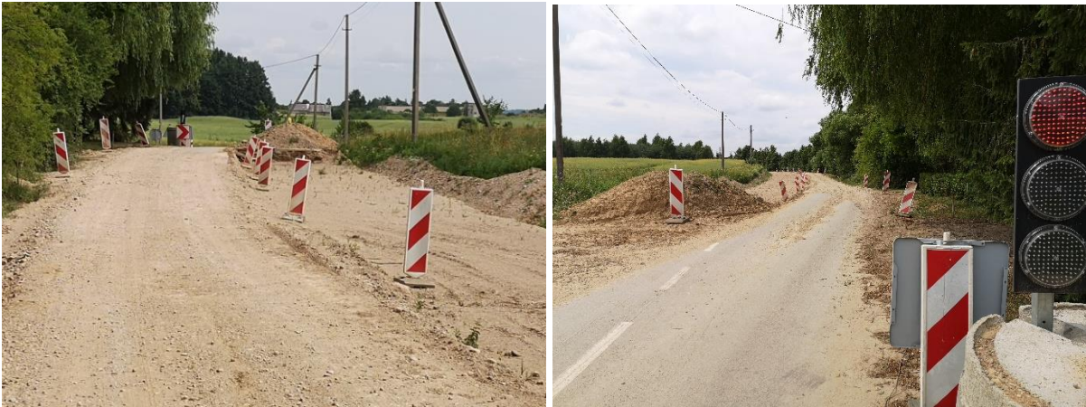
3.5 pav. Iš inertinių medžiagų įrengti fiziniai barjerai (fotografuota autoriaus 2021)
