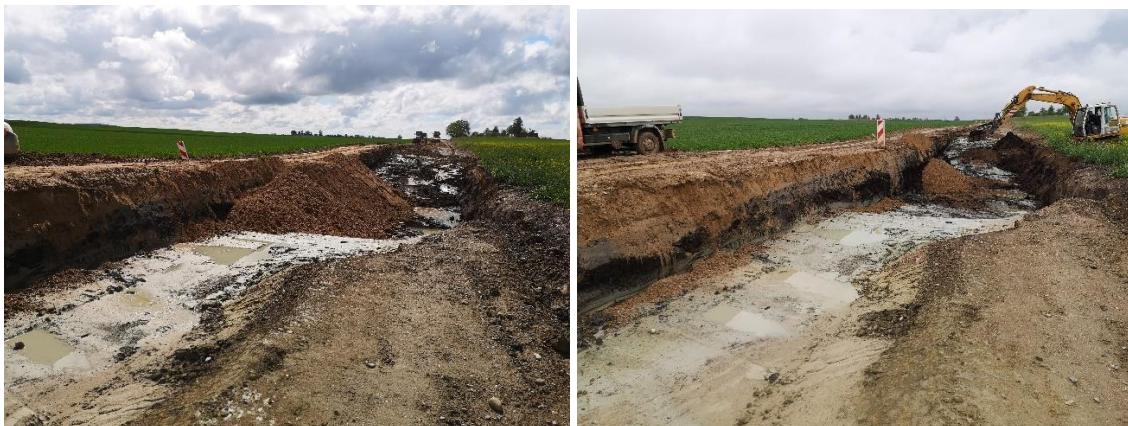
3.14 pav. Humusinio grunto keitimo darbai (fotografuota autoriaus, 2021)
