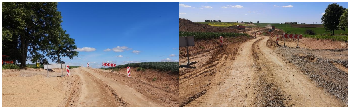
2.9 pav. Nestandartinių darbo zonų aptvėrimo sprendimai (fotografuota autoriaus, 2021)
