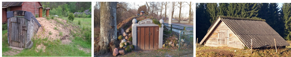
82 pav. Kiemo rūsiai: a) lieto betono 1931 m., b) mūro 1926 m., c) rąstinis.
