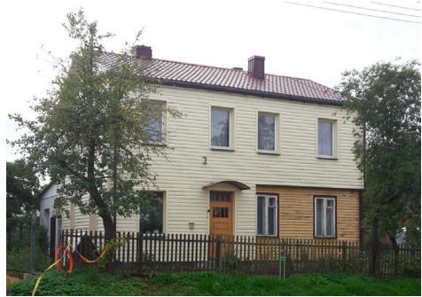
90 pav. Apkalimas plastikinėmis dailylentėmis: a) Fragmentinė, b) dalinė rekonstrukcijos
