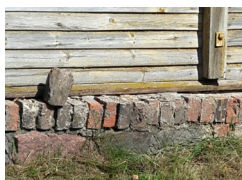
68 pav. Gyvenamųjų namų pamatų fragmentai: a) tradicinis akmenų mūro, b) betono, c) akmenų mūro, tinkuotas. 2017 nuotr.
