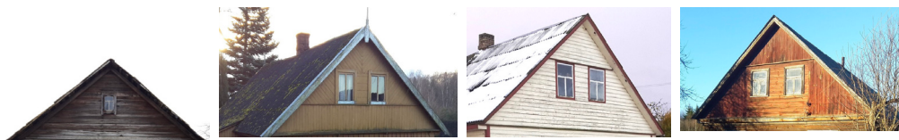
53 a–d pav. Mansardų apkalimas. a) neįrengtų, b–d) įrengtų.
