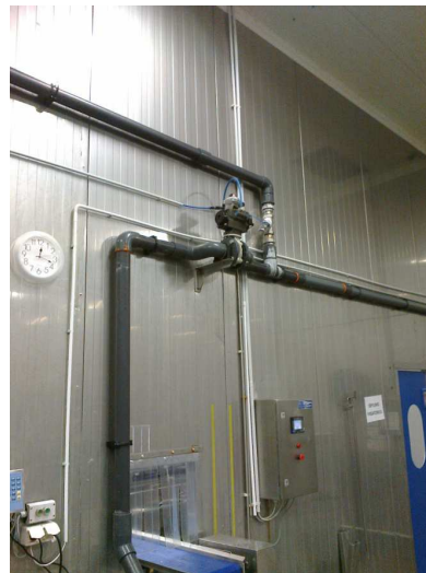
b) druskos koncentrato vamzdynas ir pneumatinė sklendė
