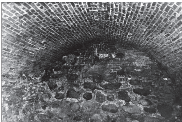
1 pav. Cilindrinio skliauto plytų rišimas gotikiniu būdu Vilniaus gyvenamojo namo Stiklių g. 4 rūsyje. Nuotrauka iš V. Levandausko asmeninio archyvo, apie 1970 m.
