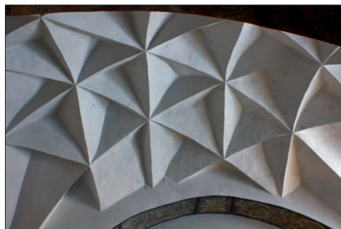
4 pav. Šešiakampės žvaigždės motyvas dominuoja Vilniaus bernardinų bažnyčios zakristijos skliautuose. 2011 m.
