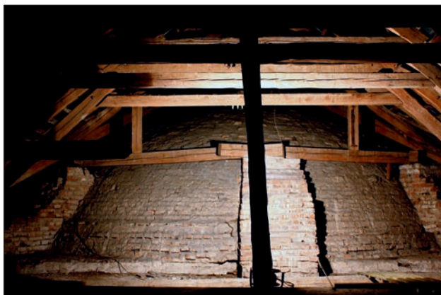
12 pav. Kauno Karmelitų bažnyčios kupolas sumūrytas trumpainiais į paviršių. 2010 m.
