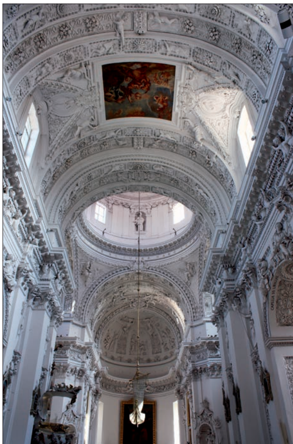
10 pav. Vilniaus Šv. Petro ir Pauliaus bažnyčios skliautus skaido travėjas skiriančios ramstinės arkos. 2011 m.
