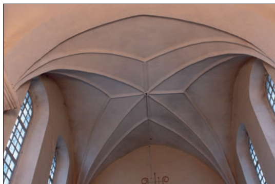
7 pav. Kruonio bažnyčios skliautų briaunas paryškina tinko „nerviūros“. 2010 m.
