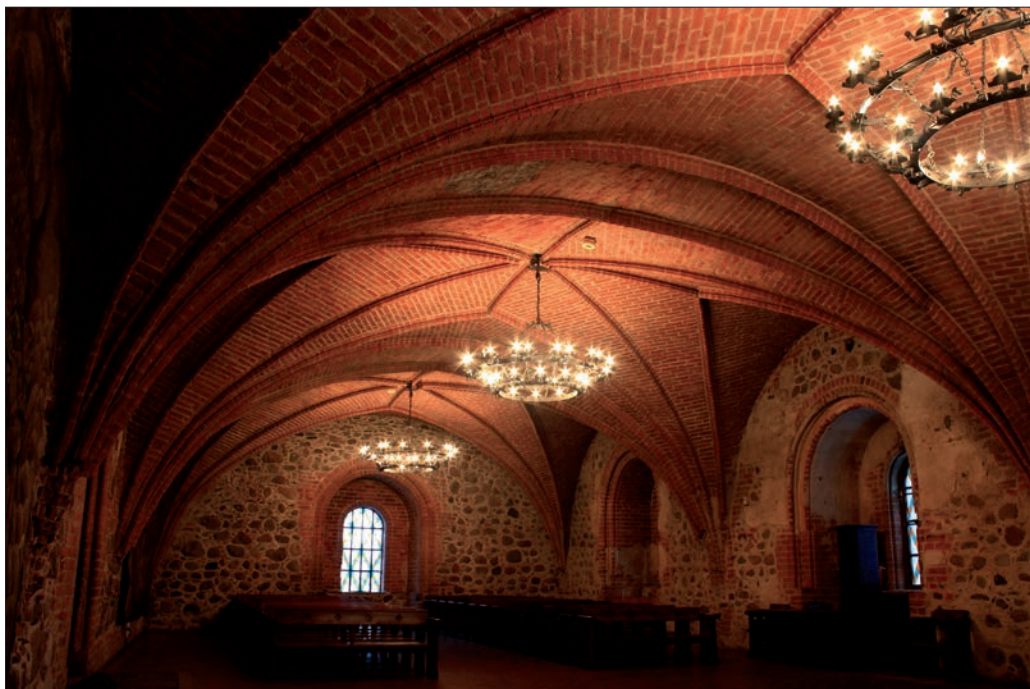
3 pav. Trakų salos pilies menės kryžminiai skliautai su liunetėmis 2010 m. Ši ir kitos nuotraukos autorias.
