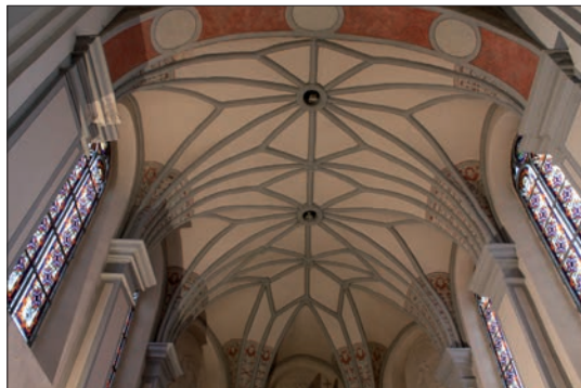
6 pav. Kauno Švč. Trejybės skliautus skaido gotikai būdingos nerviūros. 2011 m.
