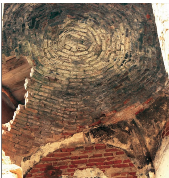
9 pav. Alšėnų pilies bokšto kupolinis skliautas, mūrytas koncentrinėmis ilgainių eilutėmis. 2009 m.
