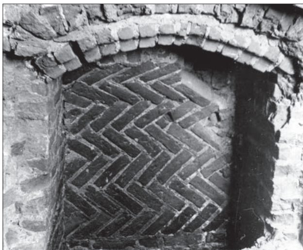
2 pav. Rūsio lango skliautukas mūrytas „eglute“ Kauno name Rotušės a. 2. Nuotrauka iš V. Levandausko asmeninio archyvo, apie 1970 m.
