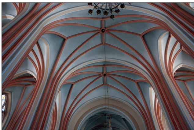
14 pav. Druskininkų bažnyčioje žvaigždiniai skliautai dengia visas travėjas. Nerviūrų plytos imitacinės. 2011 m.
