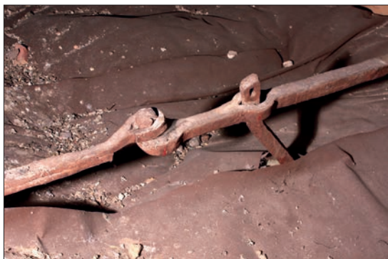
11 pav. Vilniaus Šv. Teresės bažnyčios vidurinėsios navos skliauto XVII a. templė su atatampa. 2011 m.
