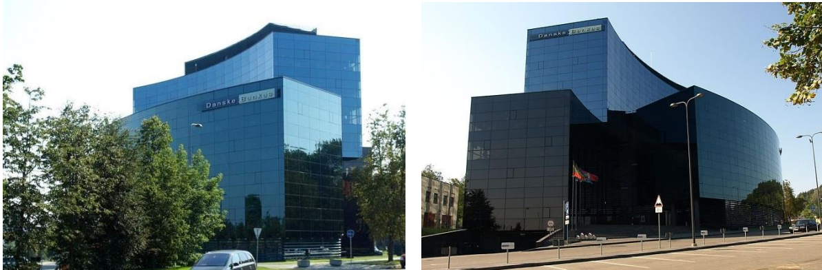
Bendras vaizdas nuo Ukmergės g. viaduko iš šiaurės ir pietryčių pusių.
