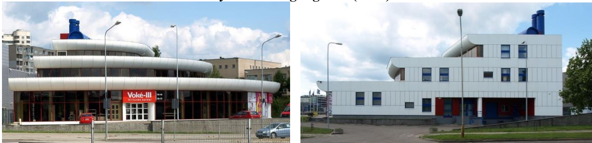
Bendras vaizdas iš Ukmergės g. nuo miesto centro pusės ir S. Nėries g. fasadas.
