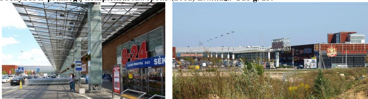
Fasado fragmentas su pagrindiniu įėjimu ir komplekso fragmentas nuo Ukmergės g. pusės.
