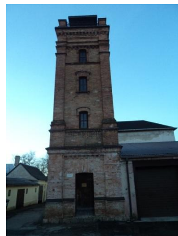
20 pav. gaisrinės bokštas
