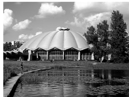
15 pav. Ledo arena Elektrėnuose, konstr. A. Kanapeckas, 1960 m.
