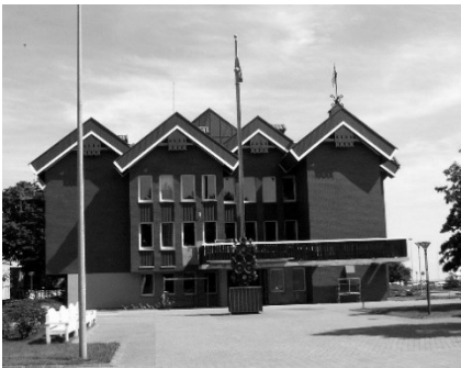
43 pav. Nidos miesto savivaldybė, archit. G. Tiškus, 1973 m. Fig. 43. Municipality center in Nida, by Architect G. Tiškus, 1973
