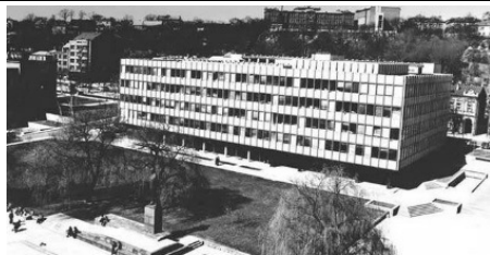
12 pav. Miestprojekto pastatas Kaune, archit. A. Sprindys, 1975 m. Fig. 12. Miestprojekto building in Kaunas by Architect A. Sprindys, 1975
