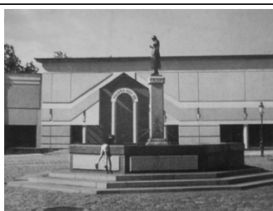
153 pav. Klaipėdos dramos teatras, archit. S. Manomaitis, 1979–1989 m. Fig. 153. Klaipėda Drama Theater, by Architect S. Manomaitis, 1979–1989 m.
