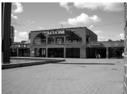
181 pav. Prekybos kompleksas Šeškinė , Vilniuje, archit. G. Baravykas, G. Ramunis, K. Pempė, 1978–1985 m.
