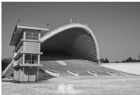
14 pav. Vingio parko dainų estrada Vilniuje, archit. A. Kotli, H. Sepmann, 1960 m.
