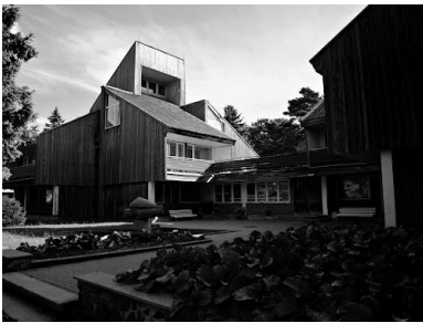
74 pav. Lietuvos Mokslų akademijos poilsio namai Palangoje, archit. V. Dičius, L. Ziberkas, 1982 m. Fig. 74. Recreation building of Lithuanian academy of Sciences in Palanga by Architects V. Dičius, L. Ziberkas, 1982
