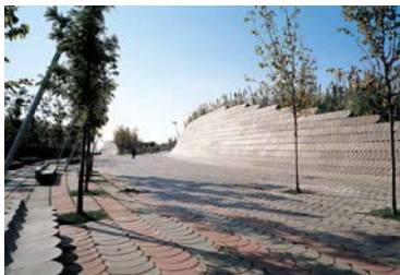
F9 pav. Erdvinio paviršiaus sprendimas tinka riedlentiniams, dviratininkams, vaikams, taip pat veikia kaip apsauginė sienelė (pvz., nuo transporto triukšmo). Pietryčių parkas, Barselona, Ispanija
