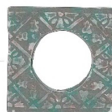
688 pav. Koklio su valymo anga pavyzdys; paplitimas pietvakarių Vokietijos ir Šveicarijos vietovėse siejamas su laikotarpiu nuo XVIII a. pabaigos iki XX a. (ROTH HEEGE, Eva. Ofenkeramik und Kachelofen... , S. 313)
