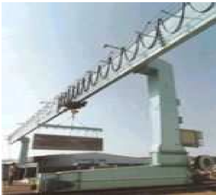
2.1.2.3 pav. Metalinė tilto konstrukcija
