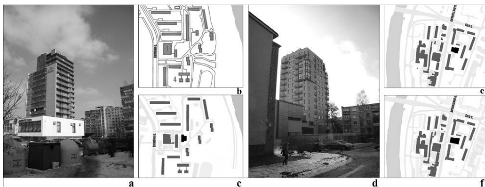
3.2 pav. Daugiaaukščiai pastatai Antakalnyje (a) vaizdas; b) pirminis planas; c) esamas planas) ir Žirmūnuose I (d) vaizdas; e) pirminis planas; f) esamas planas)
