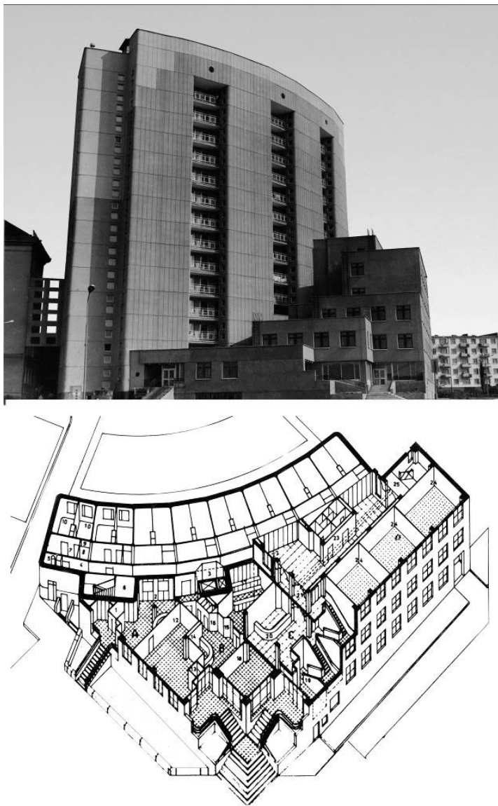
2.35 pav. Daugiafunkcinis pastatas šalia Savanorių pr. (arch. Stanislovas Garuckas, 1986 m.): a) vaizdas; b) vidaus aksonometrija Fig. 2.35. Multifunctional building near Sanavanių Ave. (arch. Stanislovas Garuckas, 1986): a) view; b) interior axonometric view
