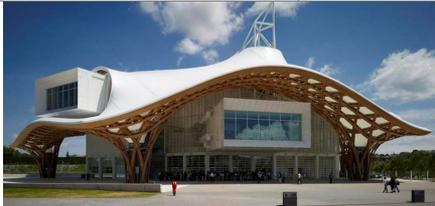
**268 pav.** Tinklinė medinių sijų kolonų ir stogo denginio struktūra „Pompidu“ centro pastate, Prancūzija, archit. S. Ban, 2010 m.
