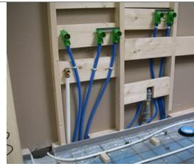
**260 pav.** Iš anksto medinėje karkasinėje sienoje išvedžiojamos inžinerinės pastato sistemos
