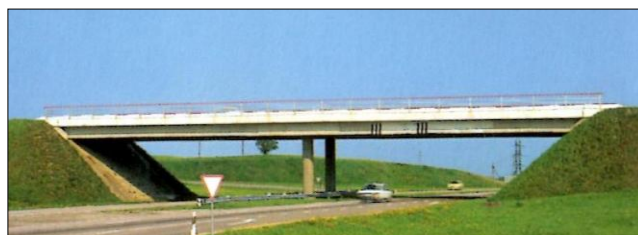
232 pav. Laukuvos viadukas, pastatytas 1987 m.
