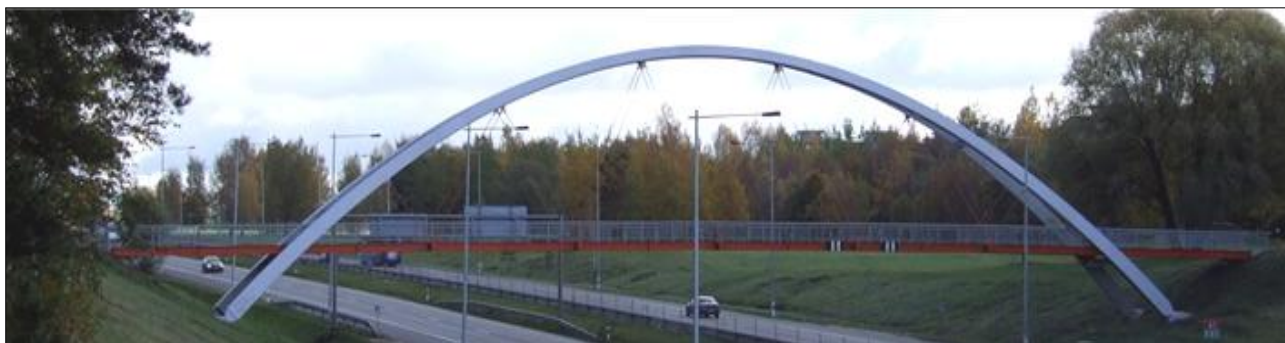
249 pav. Arkinis pėsčiųjų tiltas į Kleboniškių parką Kaune, pastatytas 2005 m. Tiltą sudaro dvi plieninės dviejų lankstų arkos, laikančios konstrukciją, aukštis virš 5 m.
