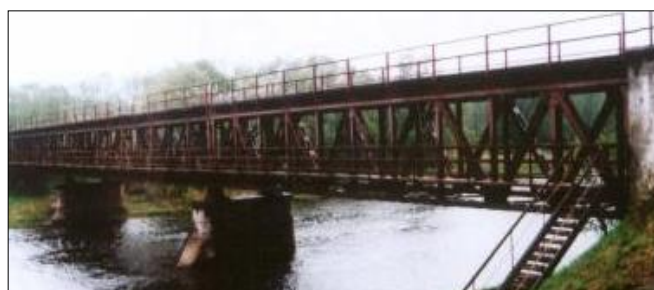
196 pav. Siaurojo geležinkelio tiltas per Šventąją ties Anykščiais.
