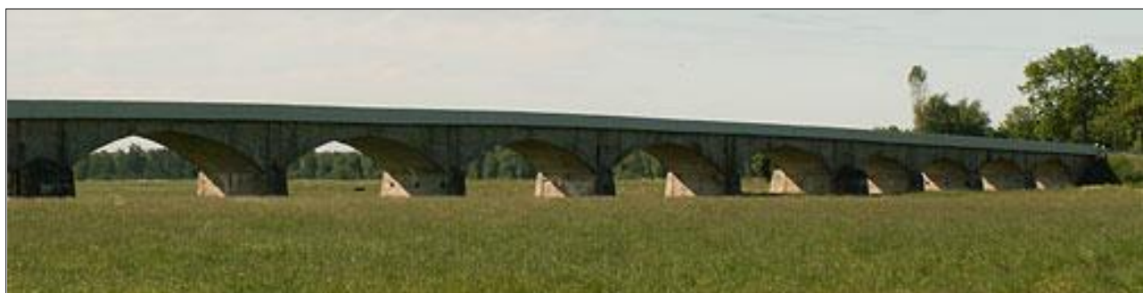
142 pav. Kazio Griniaus tiltas per užliejamas pievas netoli Šilutės. Internetinė prieiga: http://www.nemunodelta.lt/16983/kultura/architekturos-vertybes.html
