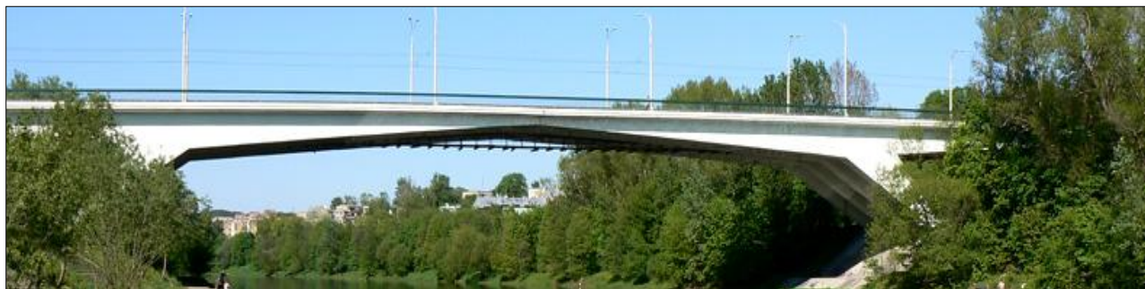
212 pav. Žirmūnų tiltas – rėminis gelžbetoninis tiltas per Nerį Vilniuje, pastatytas 1965 m. Internetinė prieiga: http://lt.wikipedia.org/wiki/Vaizdas:Zirmunai_Bridge_in_Vilnius.jpg
