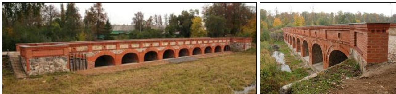
29-30 pav. Astravo dvaro tiltas-užtvanka, sumūrytas iš raudonų plytų ir lauko akmenų
