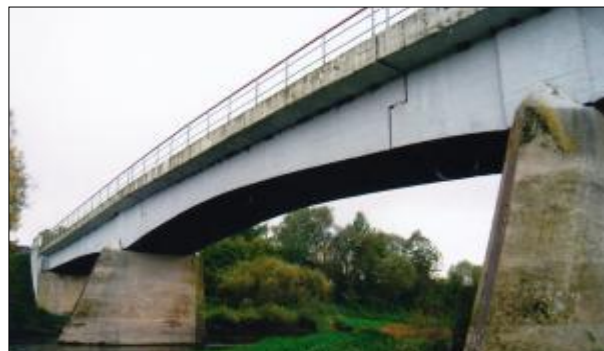
161 pav. P. Stanaičio tilto danga išgrįsta lauko akmenimis. 162 pav. P. Stanaičio tilto intarpinės sijos ir taurai. Iš H. Kebeikio kolekcijos, 2011.
