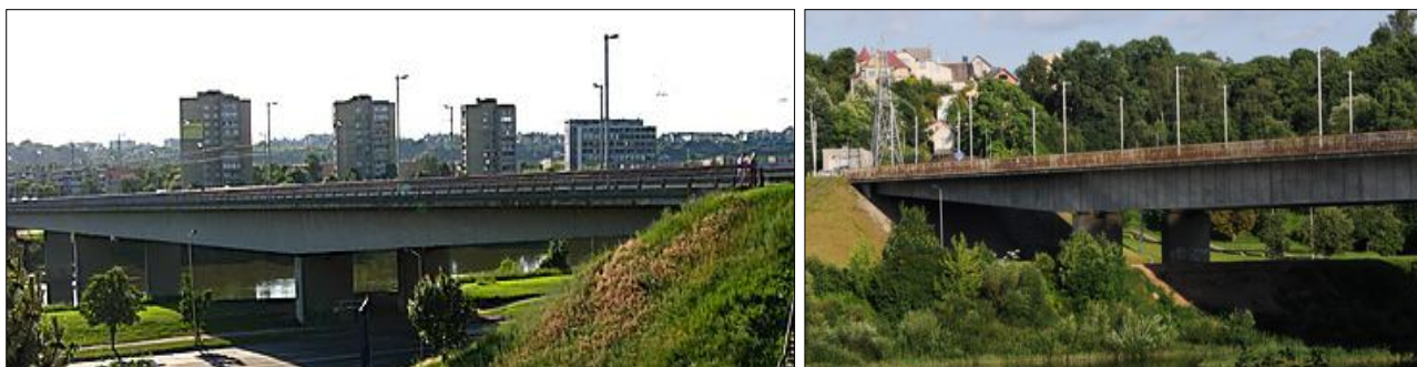
227-228 pav. Varnių tiltas per Nerį Kaune, pastatytas 1983 m.
