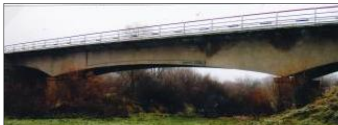
136 pav. Tiltas per Šešupę ties Pilviškiais, statytas 1926 m.
