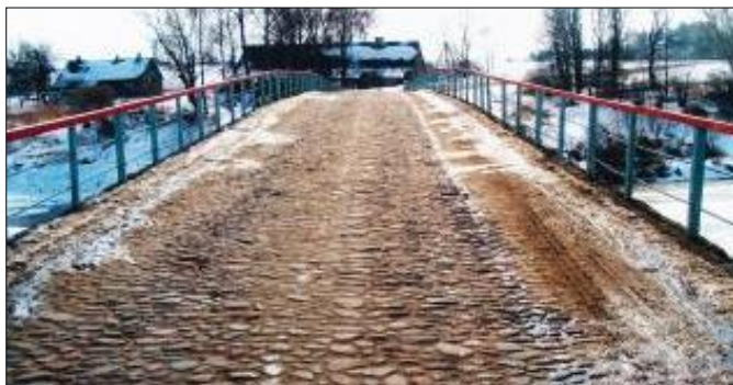
161 pav. P. Stanaičio tilto danga išgrįsta lauko akmenimis. 162 pav. P. Stanaičio tilto intarpinės sijos ir taurai. Iš H. Kebeikio kolekcijos, 2011.
