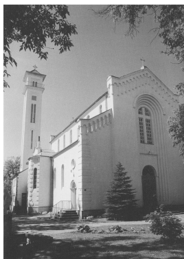
2.1.2 pav. Kybartų bažnyčia, (archit. V. Žemkalnis, 1928 m.)
