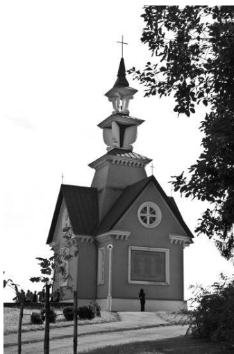
3.2.3 pav. Rainių Kančios koplyčia Telšių raj. (archit.: J. Virakas, A. Žebrauskas, 1991 m.)
