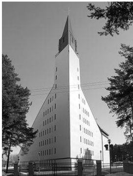
2.1.17 pav. Švč. Mergelės Marijos Jūrų Žvaigždės bažnyčia Šventoje (archit.: R. Krištapavičius ir G. Aperavičius, 1991 m.)
