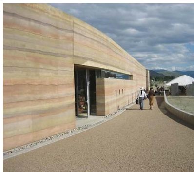
4 pav. Plūktos grunto sienos fragmentas Kanadoje
