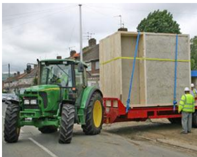
23 pav. Skydinių šiaudų namų statybos technologija :a-skydai vežami į statybos vietą; b – šiaudinis skydas
