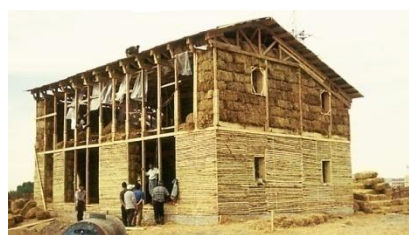
13 pav. Moterų federacijos šiaudinis pastatas, Mongolija: a – pastatytas namas; b - namas statybos metu
