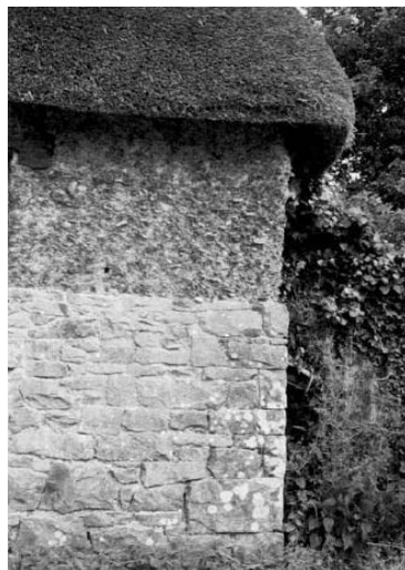
33 pav. Molinio namo laikančiosios sienos pavyzdys, Didžioji Britanija, Devonas
