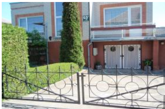
35 pav. Lankstyto metalo tvora Ukmergės 63b, Šiauliai
