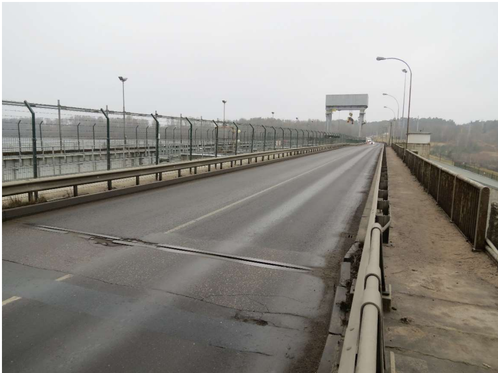
2.2 pav. Tilto vaizdas nuo Petrašiūnų pusės
