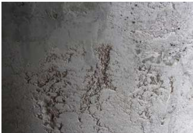
1.5 pav. Monolitinės betono konstrukcijos paviršiaus iškorėjimas (autorius nuotrauka)
