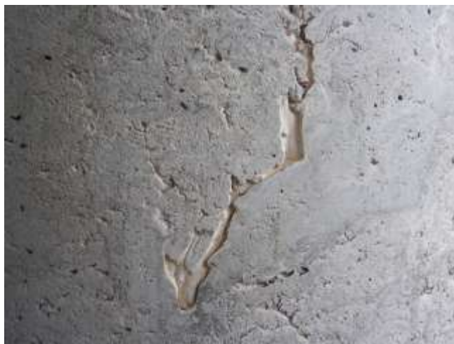
1.6 pav. Išplauta cemento tešla klojinių sienelių paviršiuje (autorius nuotrauka)
