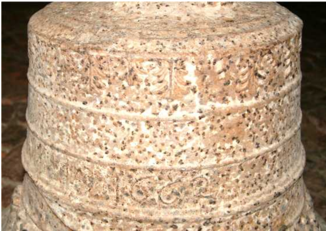
3. Varni 1662 m. varpo korpuso viršutin dalis su akanto lap seka ir nulieta pagaminimo data.
