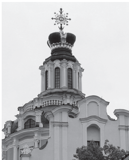
4.13 Šv. Kazimiero bažnyčios kupolo šalmas, pagal archit. J. Muloko projektą, 2006
