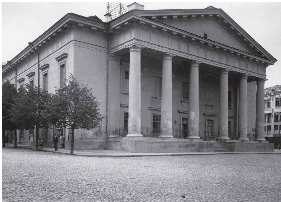
3.6 Rotušės pastatas prieš rekonstrukciją, iki 1937
