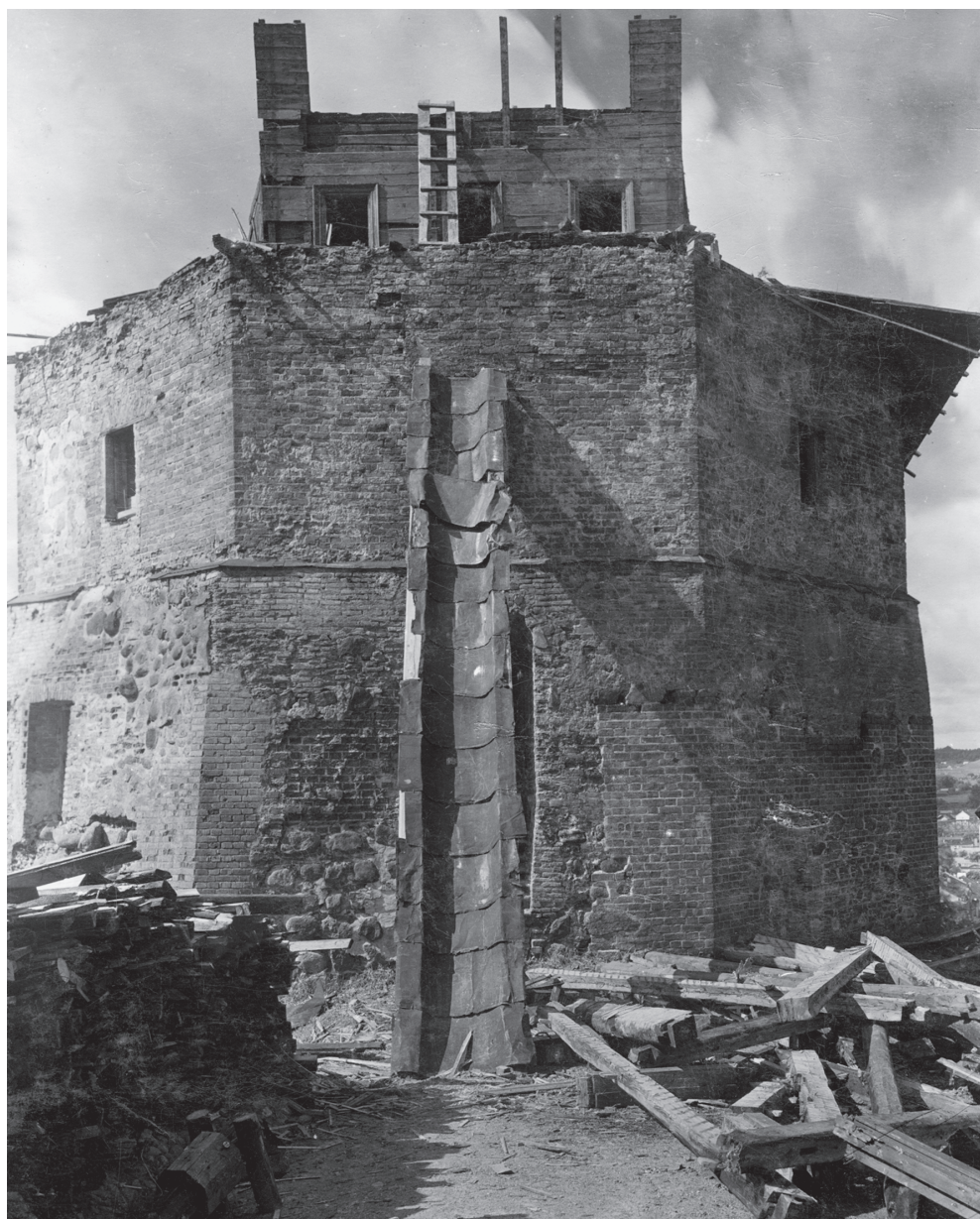
3.9 Aukštutinės pilies vakarų bokšto medinio antstato griovimas, fotografas J. Buļhak, 1930
