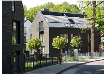
94 pav. Daugiabučiai gyvenamieji namai Krivių g., Vilniuje, T. Balčiūnas, V. Biekša, 2009 m. realizuota komplekso dalis Fig. 94. Apartment blocks in Krivių St., Vilnius, by T. Balčiūnas, V. Biekša, 2009
