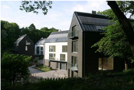
93 pav. Daugiabučiai gyvenamieji namai Krivių g., Vilniuje, T. Balčiūnas, V. Biekša, 2007 m. realizuota komplekso dalis Fig. 93. Apartment blocks in Krivių St., Vilnius, by T. Balčiūnas, V. Biekša, 2007
